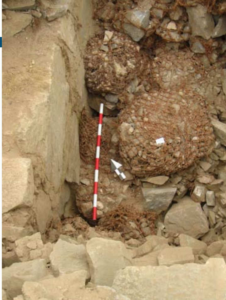
TÉCNICA SISMORRESISTENTE: DEPÓSITO CONSTRUCTIVO EN BOLSAS DE FIBRAS VEGETALES O SHICRAS
